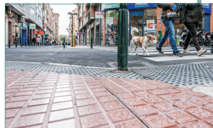
Imatge 18. Cruïlla amb plataforma sobreelevada per a vianants.
