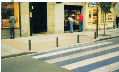
Imatge 10. Pas per als vianants amb gual de tres rampes amb construït amb "paviment de botons" de color contrastat. La instal·lació de bollards suposa un obstacle per a persones amb deficiències visuals.
