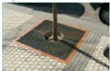
Imatge 9. Escossell cobert per una reixa en dues peces, amb cel·la de 20 x 20 mm correctament enrasada amb la vorera.
