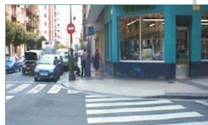
Imatge 12. Gual incorrecte en cantonada.
