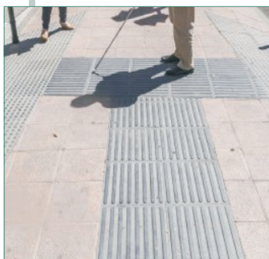
Imatge 37. Paviment podotàctil.
