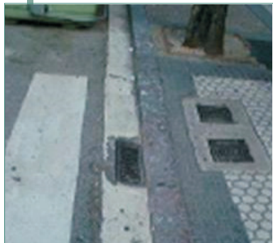
Imatge 7. Reixa malament situada ja que ocupa part de l'àrea destinada al trànsit dels vianants.
