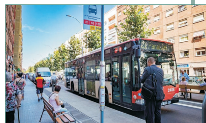
Imatge 26. Plataforma d'avançament de la vorera en una parada d'autobús.
